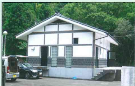
地藏寺クリーンセンターの建屋
