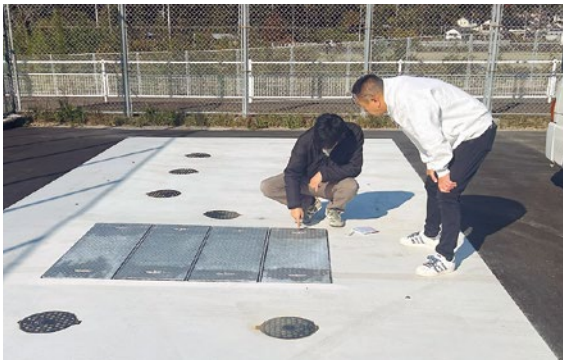
土佐町小中学校に設置された災害用トイレタンク
