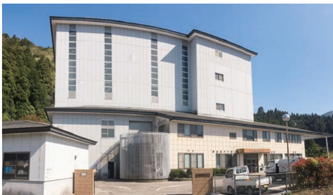
嶺北広域清掃センターのトラックスケール補修のため 嶺北広域分担金を補正(嶺北広域行政事務組合HPより)
