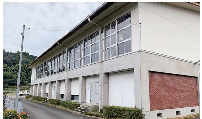
小中学校体育館、武道場に移動式エアコン設置のため 電気工事が行われる
